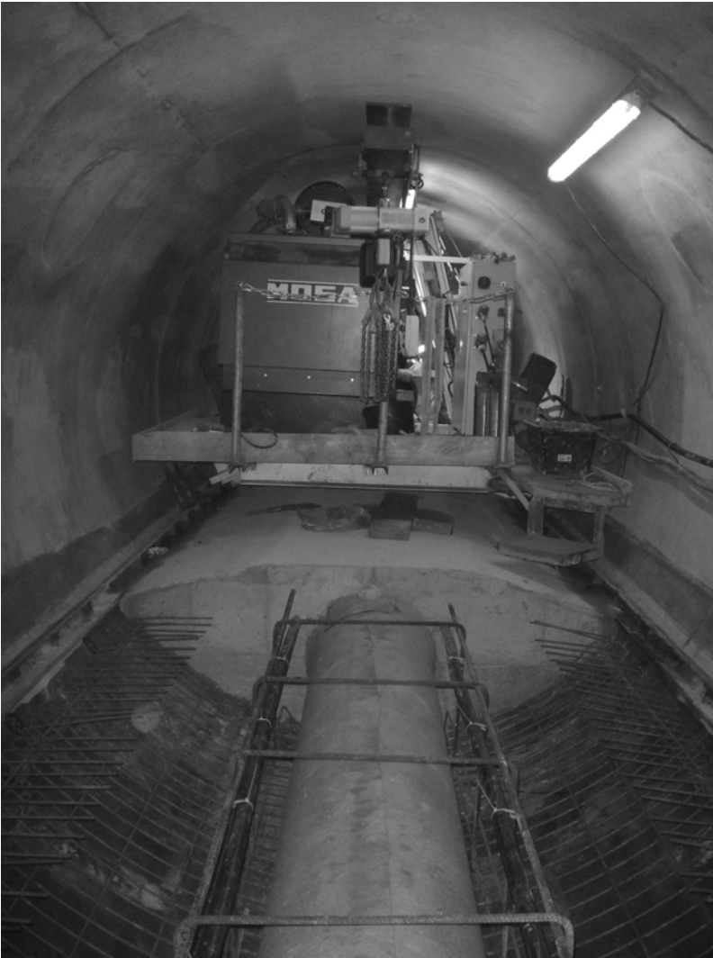
Bild 2: Einbau Rohrleitung und Sohlbeton in fertig gestellter Betoninnenschale
