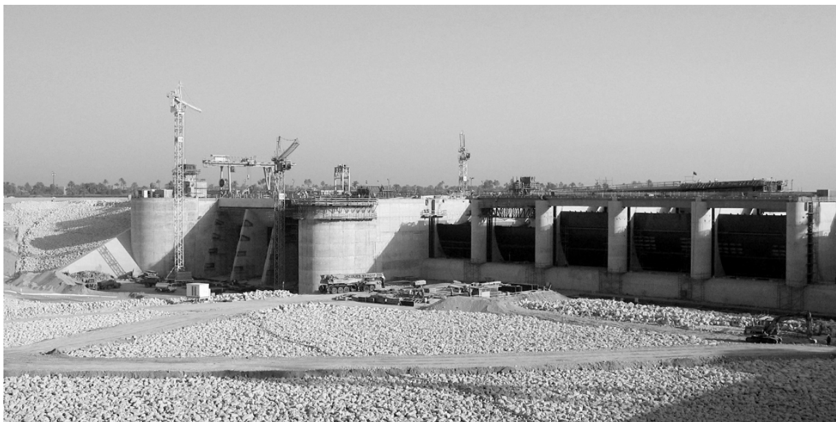
Bild 3: Ansicht von Kraftwerk und Wehr von oberstrom
