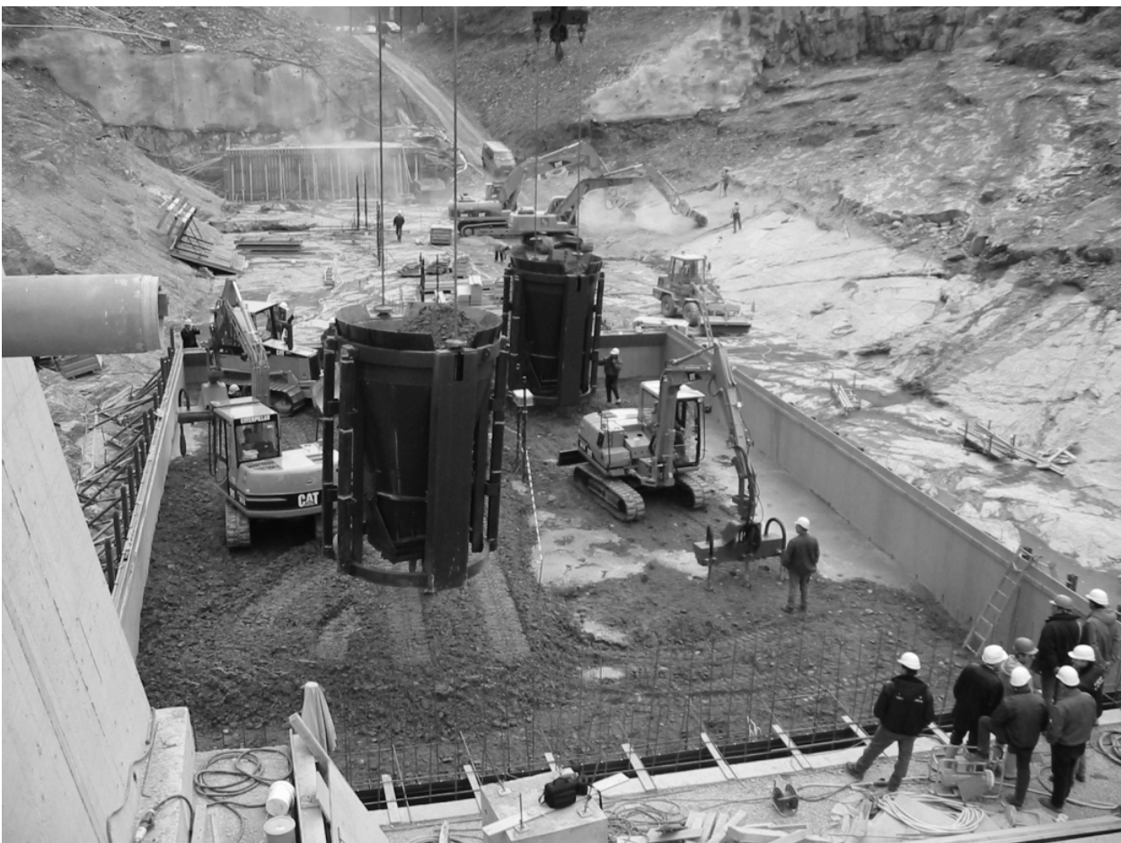
Bild 2: Blockbetonage mit Geräteanordnung
