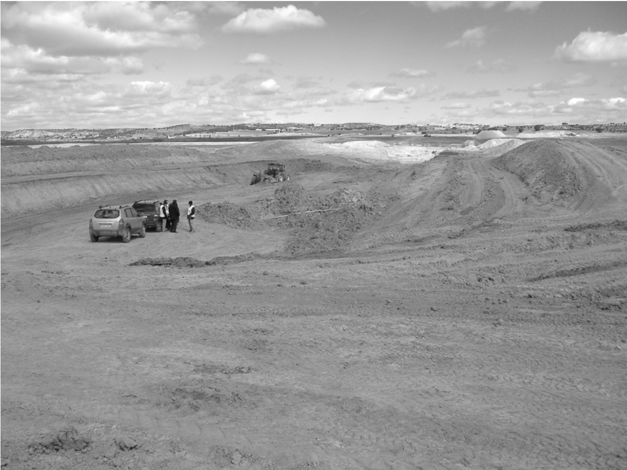
Bild 3: Aushebung der Gründungssohle der Sperre A
