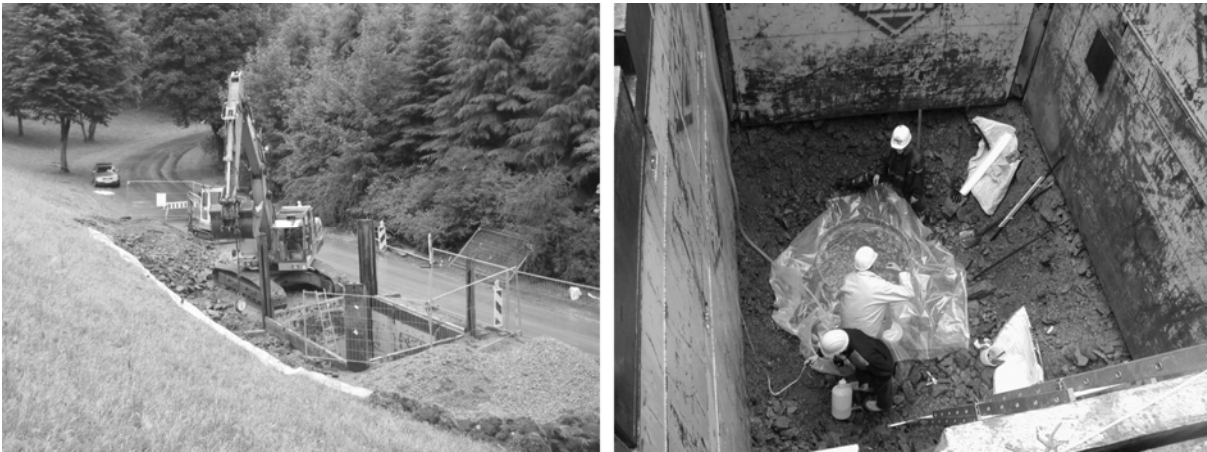
Bild 2: Schürfgrube am Dammfuß und in situ-Dichtebestimmung
