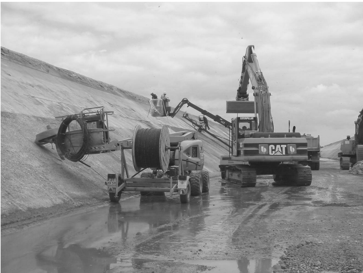
Bild 1: Isarkanal Haltung ‚Speicherseen‘ – Nuterstellung und Kabelverlegung
