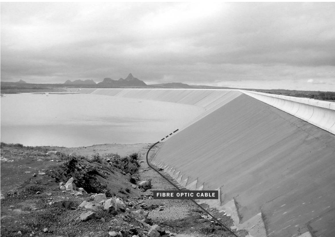
Bild 3: Merowe Dam Sudan – Installation des faseroptischen Kabels
